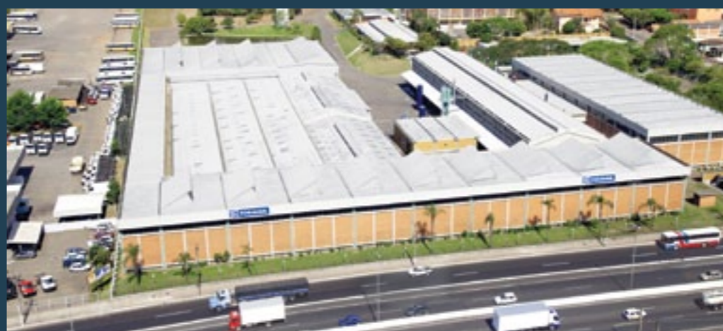
Forjasul Canoas S. A. Ano de fundação: 1959 Localização: Canoas - RS Área construída: 26.630 m 2 Número de funcionários: 162 Produção: morsas, machados, marretas, ganchos para içamento de cargas, forjados sob encomenda e eletroferragens para linhas de transmissão de energia elétrica.
