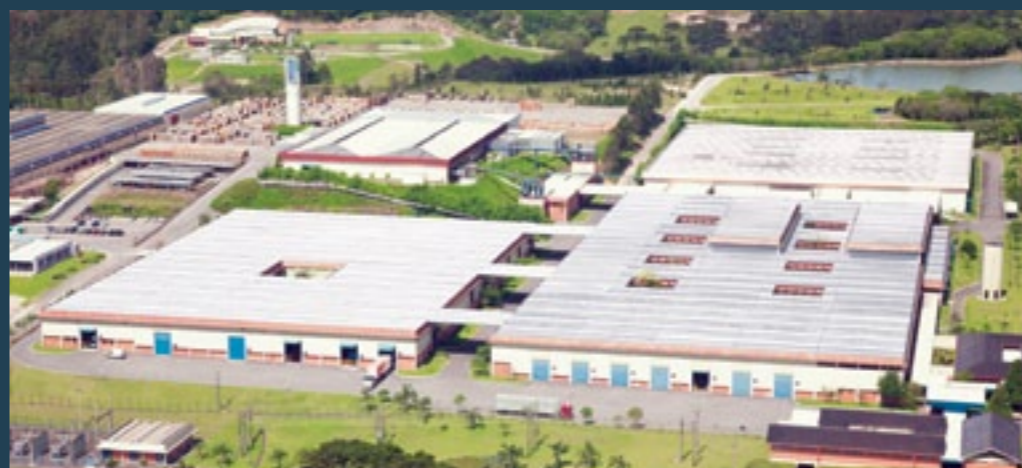
Tramontina Multi S. A. Ano de fundação: 1981 Localização: Carlos Barbosa - RS Área construída: 83.872 m 2 Número de funcionários: 761 Produção: ferramentas para jardinagem, agricultura e construção civil.
